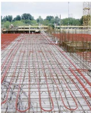
Effiziente Heizung und Kühlung mit Geothermie und Betonkern-temperierung
